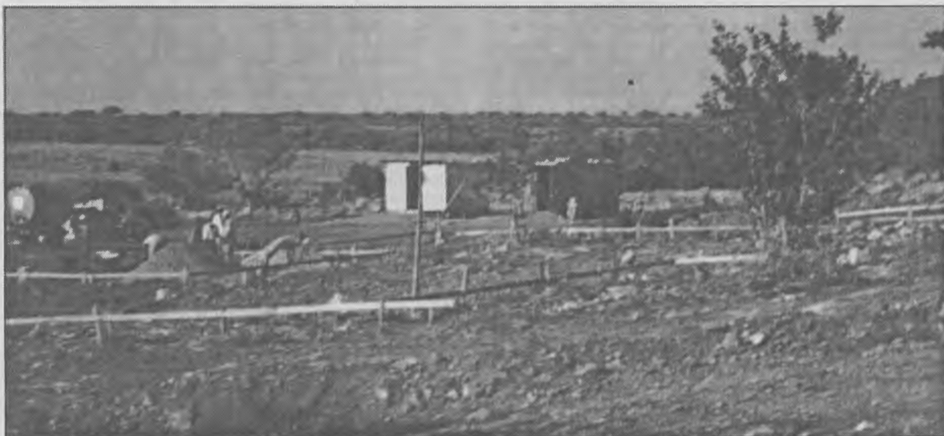
Dos caboucos nasce a nova Casa do Galato de Moçambique
